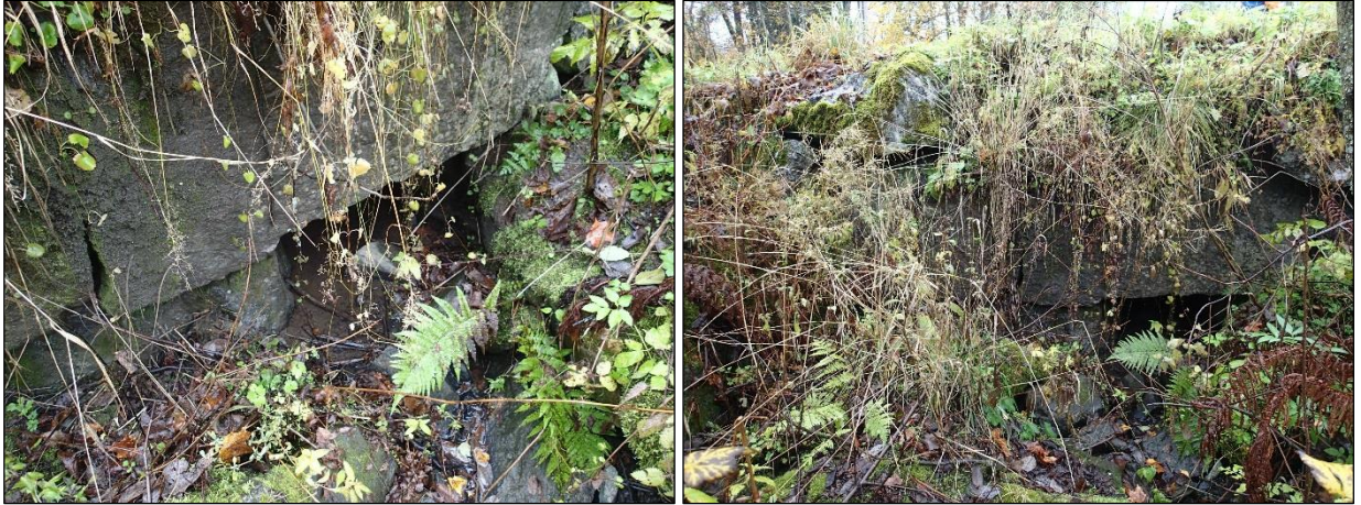
Havainto C. Siltarakennetta tien eteläpuolella.
