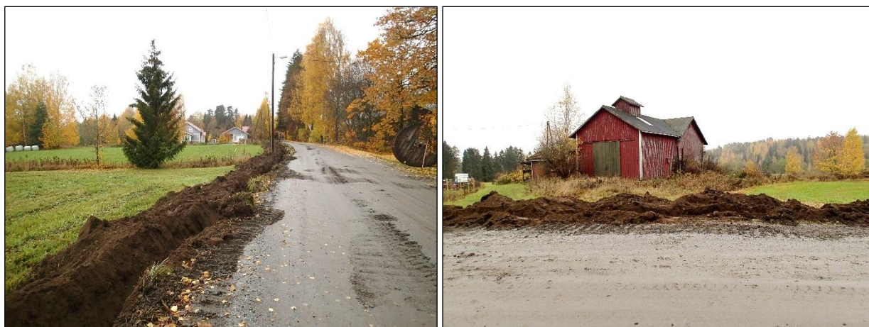
Vasen. Maakaapelinjaa Korvolantien eteläpuoleisessa tiepenkassa. Oikea. Maakaapelinjaa Korvola by muinaisjäännösalueen pohjoispuolella. Ladon edustalla ojassa havainto B .
