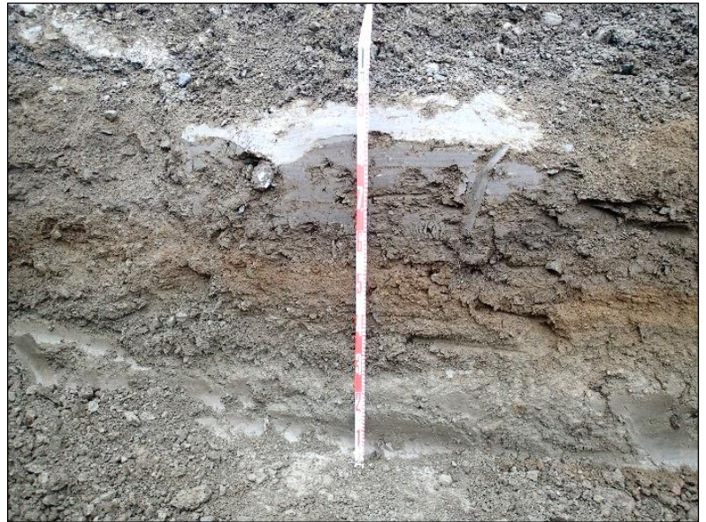
Vanhan tielinjan kohdalle kaivettu maakaapeliota.
