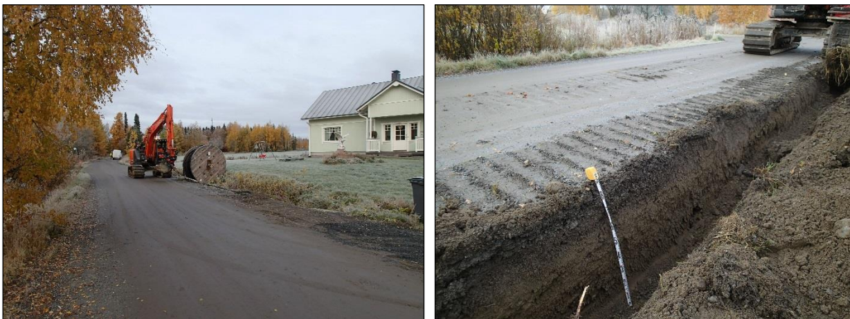
Vasen. Kaapelinjaosuus ennen valvontaa. Aloitus kaapelikelan kohdalla ja loppu valkoisen pakettiauton tasalla. Länteen. Oikea. Näkymä tien pohjoispuolen kaivannon maasta.
